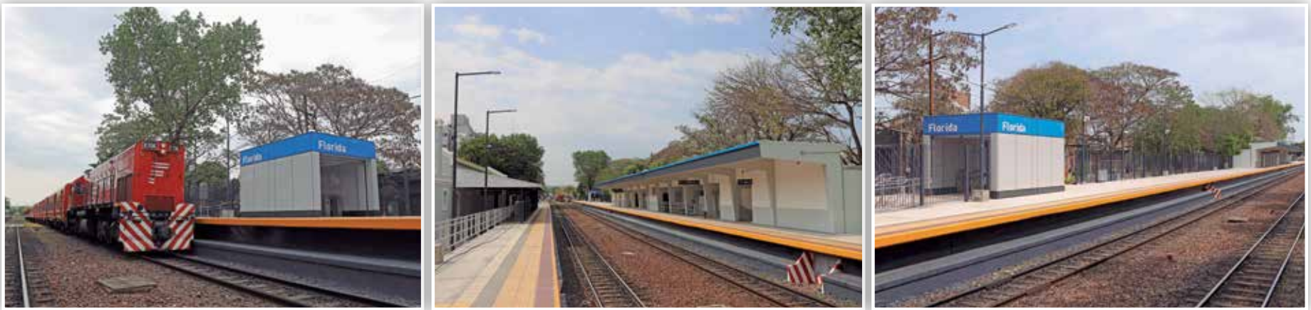
La renovada estación Florida de la línea Belgrano Norte, que ahora cuenta con mejores espacios para esperar el tren y accesos para personas con movilidad reducida.
